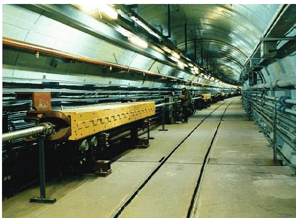
Фиг. П2. 53. Каналът за транспортиране на протоните от У-70 до УНК – [13]
